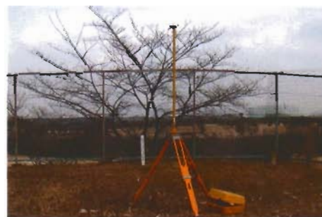
▲土砂災害現場の作業風景
